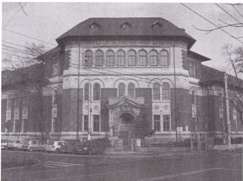
Arhitecții Virginia Haret, N. Stănescu Bd. Dacia 117 sector 2 construcție din deceniile trei și patru ale secolului XX.
