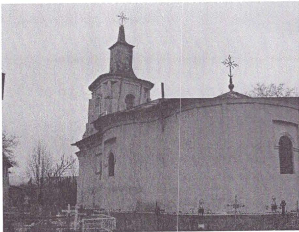
Fig. 4. Vedere Sud – Est.
