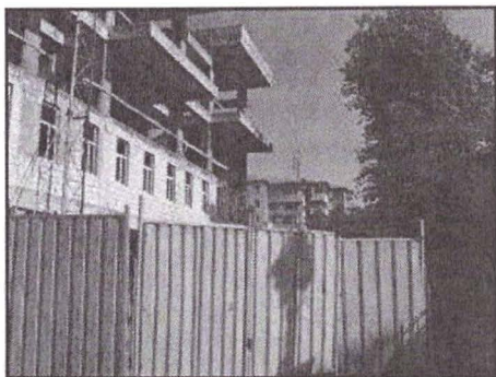
Fig. 16. Facultatea de Bioinginerie medicală – corp anexă
