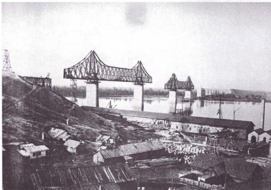
Șantierul podului și fragmente paliere pe picioare
